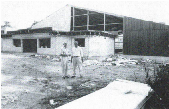
Der TuRa-Vorsitzende Alfons Bernard und der Verantwortliche des Tennishallenbaus Josef Schulte auf der Baustelle der Dreifeldtennishalle
